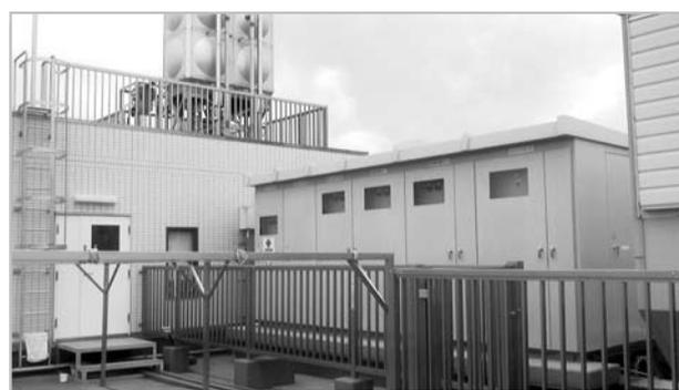
図3 津波に耐えた透析施設：屋上設置の自家発電機
